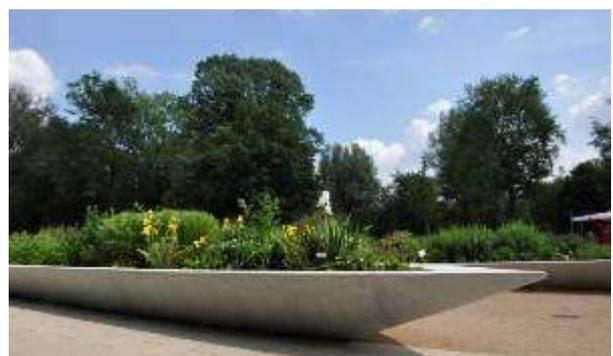
*Bei diesem Pflanztrog findet man die Schiffsform wieder. Die Fertigung aus Spritzbeton ohne Schalung entspricht höchster Handwerkskunst.*
