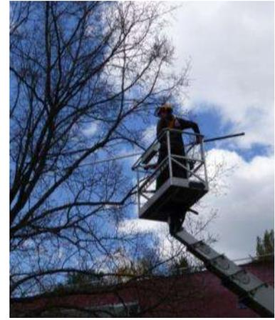
*Ein Ast wird von der Hubarbeitsbühne aus mit der Stangensäge zerkleinert.*
